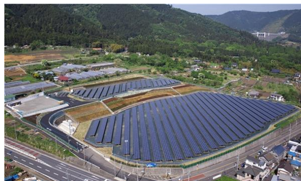
県 愛川太陽光発電所
